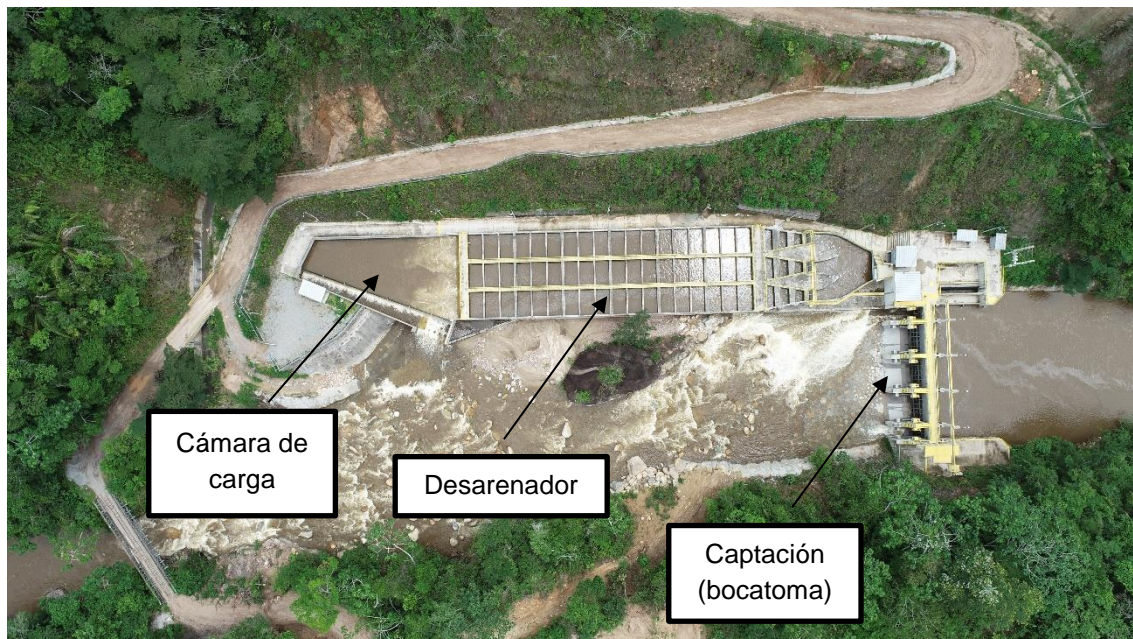
Fotografía 1. Componentes de captación
