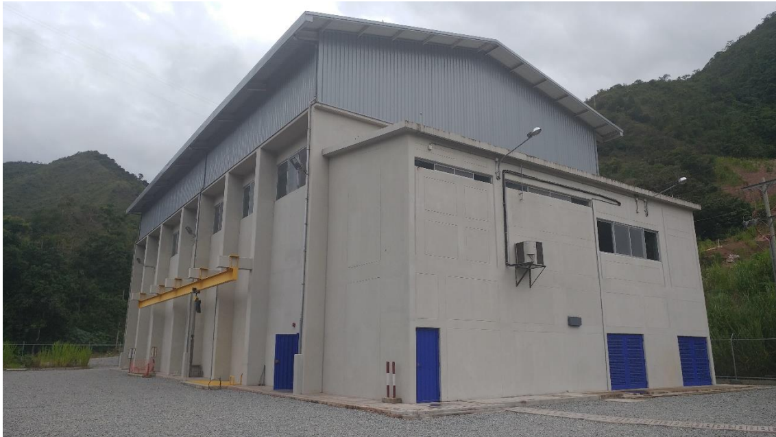
Fotografía 3. Casa de máquinas
